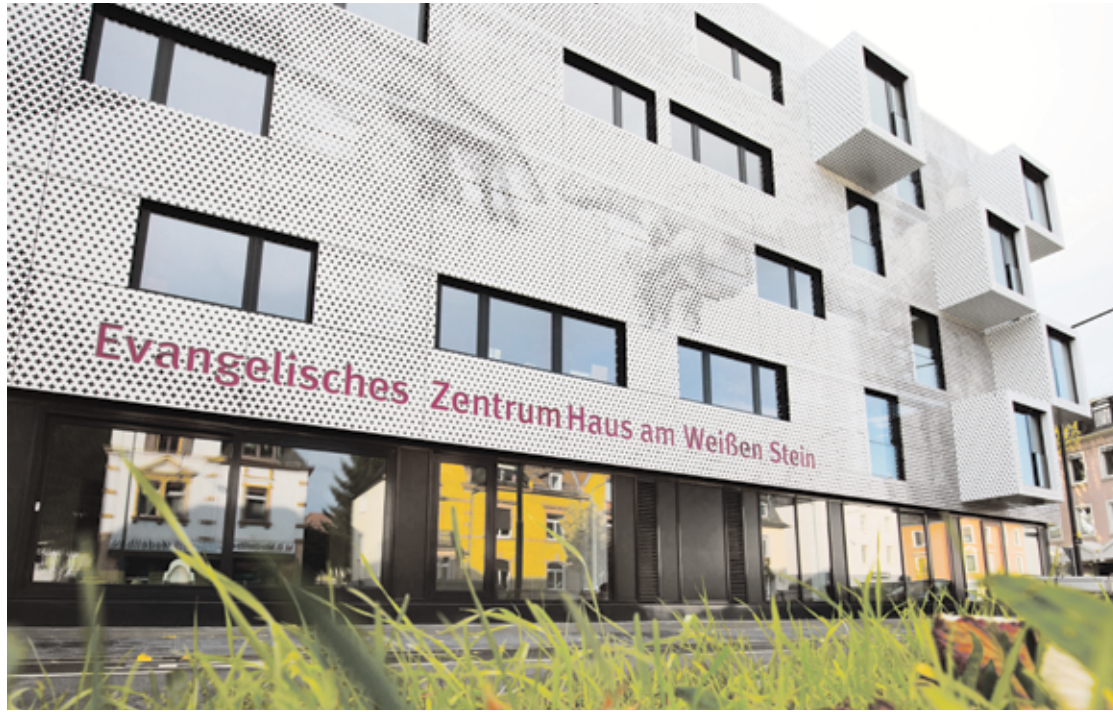
„Herausragend“: die neue Fassade des Beratungszentrums „Haus am Weißen Stein“.
